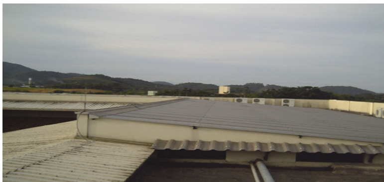
Figura 1: Vista do telhado da Unifebe – Bloco C
