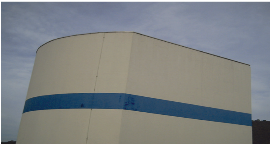
Figura 4: Vista do telhado da caixa d'água entre os blocos A e C
