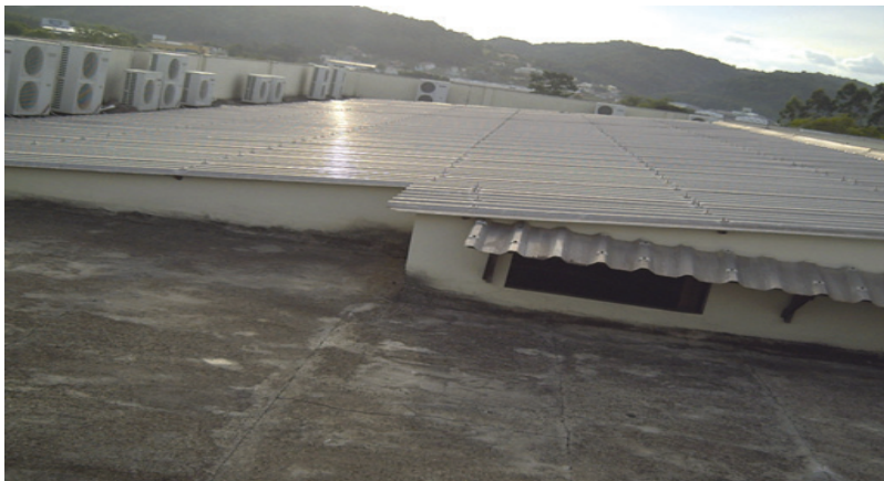
Figura 2: Vista do telhado da Unifebe – Bloco C Fonte: Os autores (2009)
