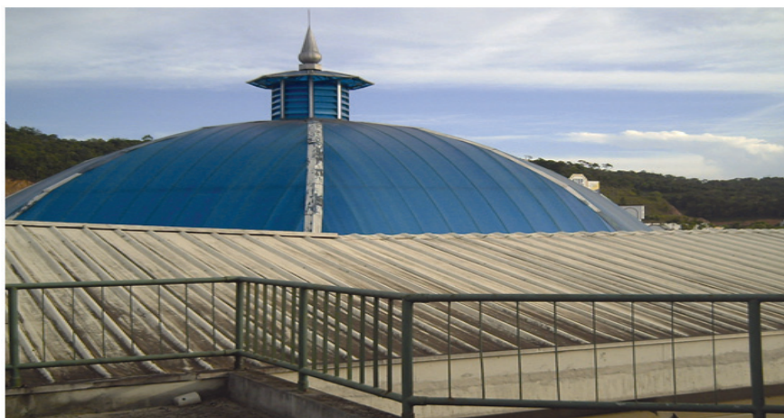
Figura 5: Vista do telhado da Unifebe - Bloco A
