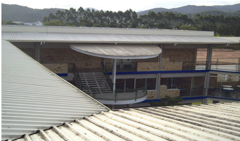
Figura 3: Vista do telhado da Unifebe – Bloco C Fonte: Os autores (2009)
