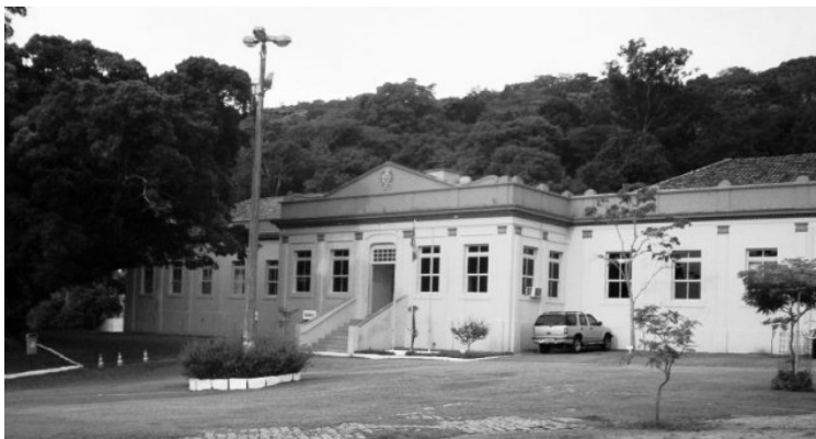
Figura 24 - Foto entrada do Hospital
