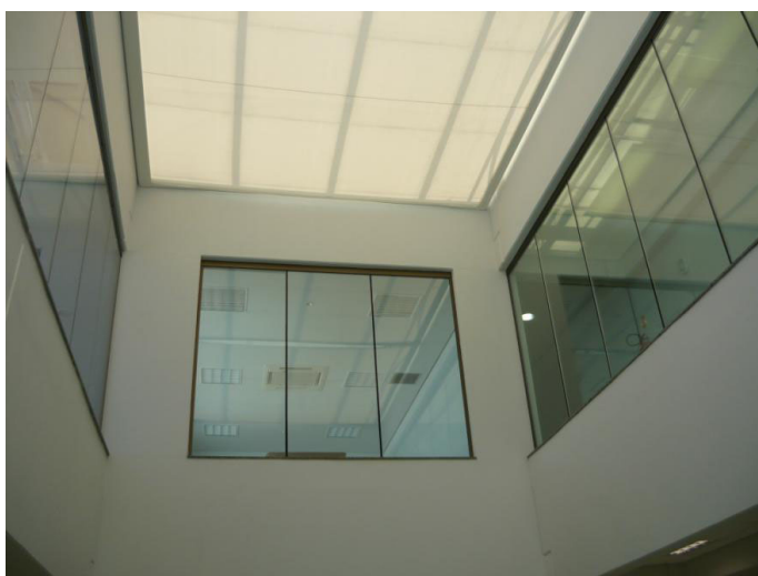
Figura 9 – Fosso de luz – Entrada pelo teto do segundo andar
